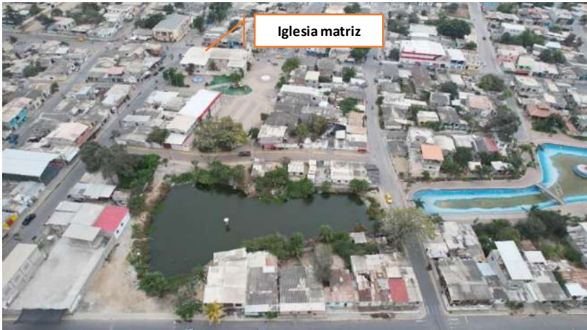
Ilustración 33 Albarrada “Centenario”, ubicada en el centro de la parroquia.
